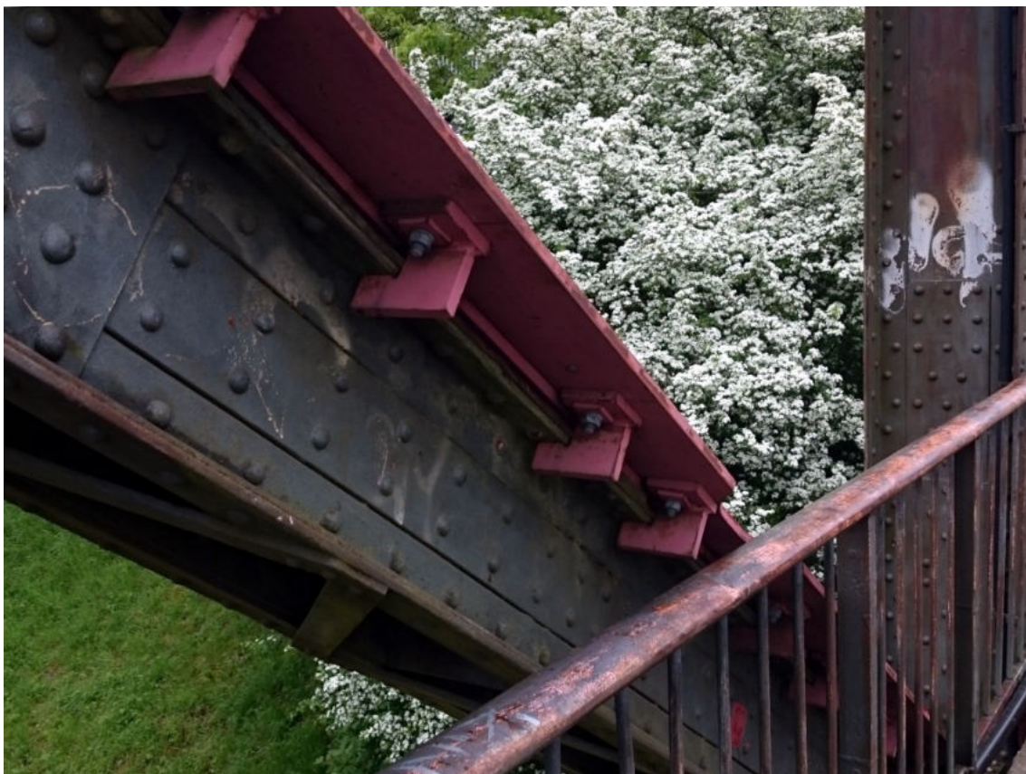
Hiltruper Prinz-Brücke: Dicke Stahlplatten krallen sich an das Tragwerk (30.4.2018; Foto: Henning Klare)
