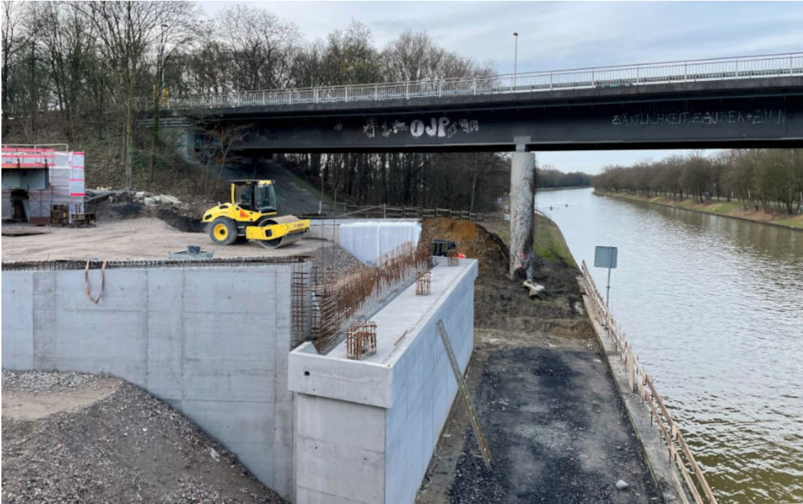
Wiederlager der neuen Brücke (Baufeld der vierten Prinz-Brücke, zwischen den Planen ein Teil der neuen Brücke (10.2.2024; Foto: Henning Klare)
